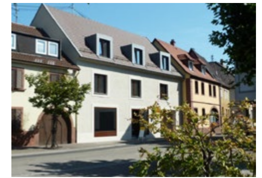
Neubau Wohn- und Geschäftshaus, Albersweiler
