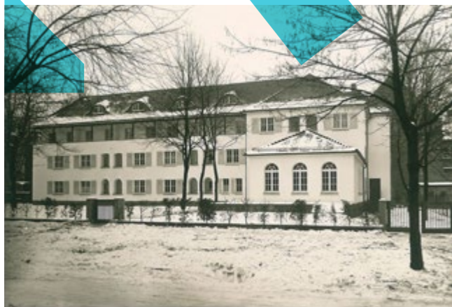
Franz-Rohde-Haus, Karlsruhe, Foto 1938
